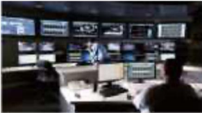
Centro di comando e controllo
