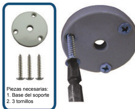
Ilustración 2: Atornille la base al techo
